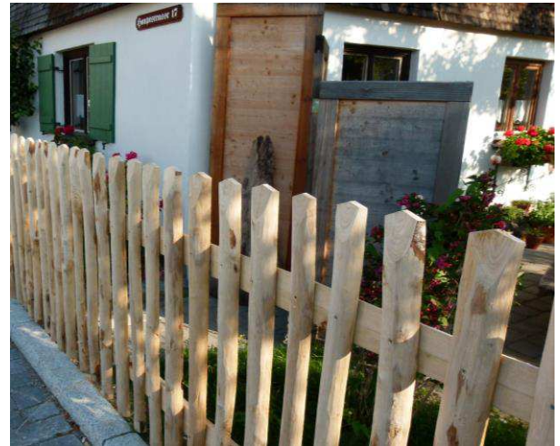
Der Lattenzaun aus halbierten, naturgewachsenen Latten mit abgeschrägter Spitze.
