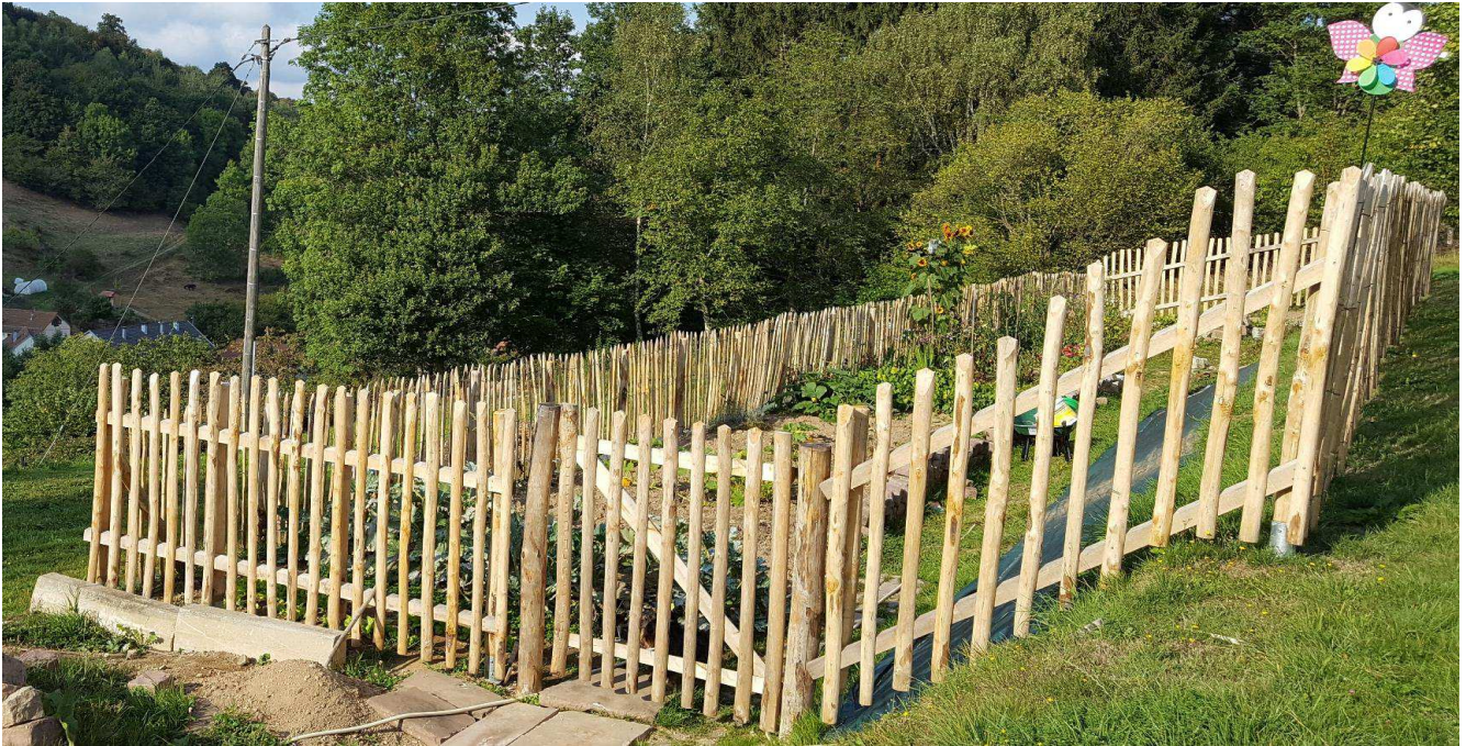
Der Lattenzaun aus halbierten, naturgewachsenen Latten mit abgeschrägter Spitze.
