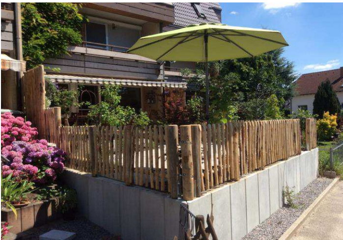
Der Lattenzaun aus halbierten, naturgewachsenen Latten mit abgeschrägter Spitze.
